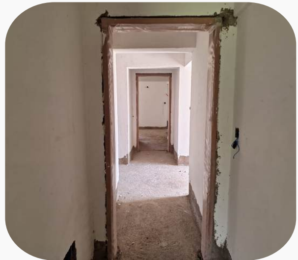
Timber door frame
